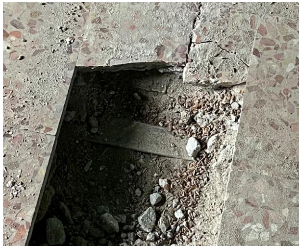
Particolare solaio Poutrelle e tavelloni
