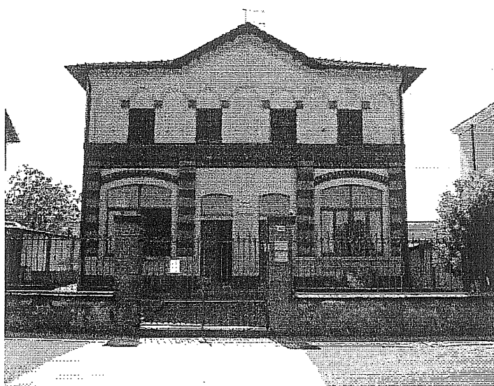
Punto 2: Presso parcheggio di fronte alla Casa dei Ragazzi e al Municipio – vista della Casa dei Ragazzi
